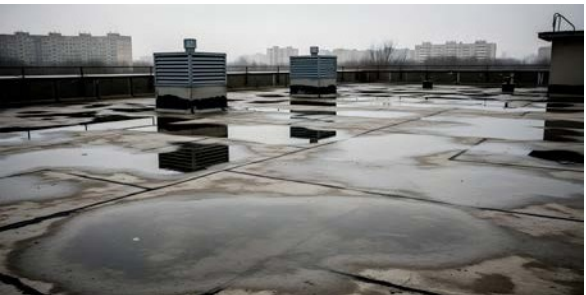
renovace plochých střech
